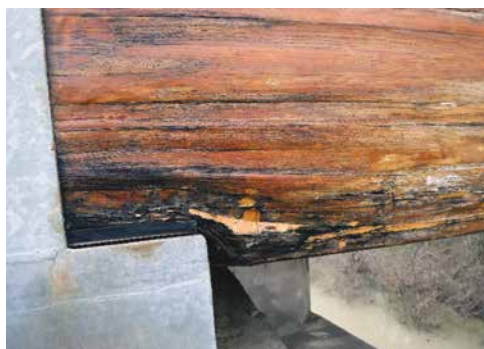
1A e 1B. Fenomeni di marcescenza delle travi in legno lamellare
