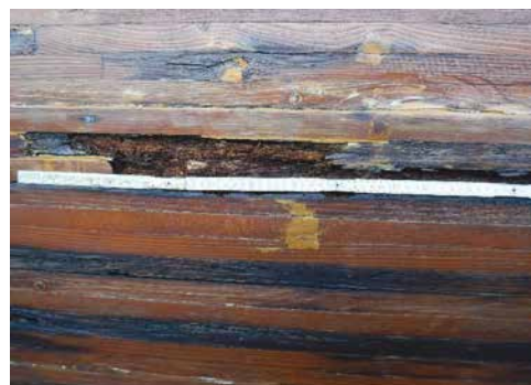
1A e 1B. Fenomeni di marcescenza delle travi in legno lamellare
