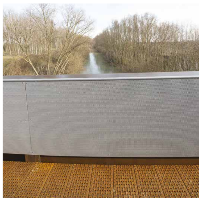
6. Dettaglio dei rivestimenti interni
