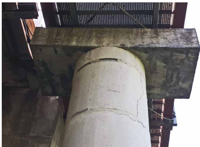
2. Dettaglio delle pile esistenti
